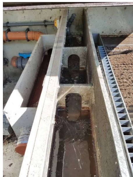
Vue du système d'alimentation du décanteur lamellaire en sortie de biodisque
