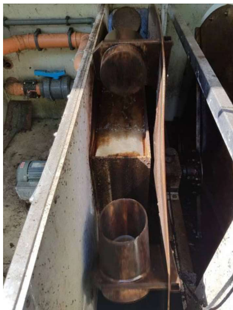
Vue du système d'alimentation du décanteur lamellaire en sortie de biodisque
