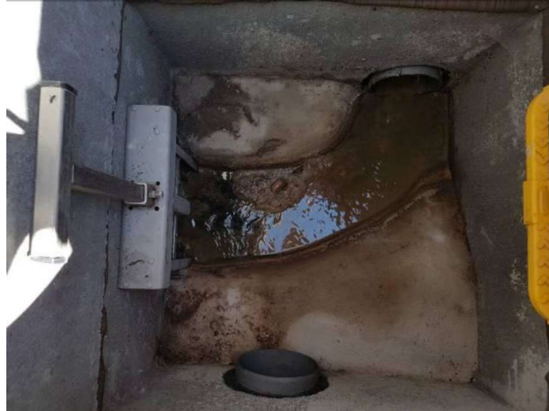
Vue du regard de changement de direction
