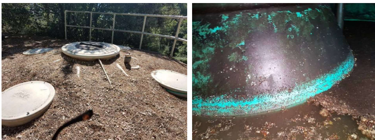
Vue extérieure du décanteur-digesteur et de la jupe intérieure
