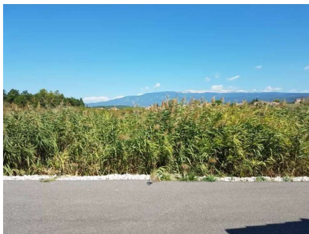
1 er étage de filtre planté de roseaux
