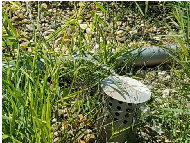
Jet arrivant dans une des cheminées
