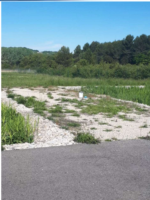
Implantation du pluviomètre sur la STEP de Blauvac
