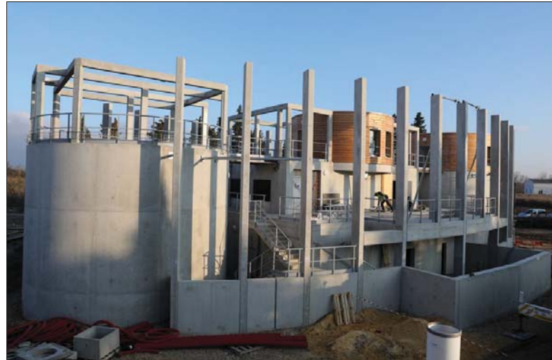
Plus moderne et plus sûre, la nouvelle usine de production d'eau potable de la Jouve est en cours d'achèvement après 20 mois de travaux. Ci-contre, Germain Vayson, responsable maintenance du site, et Julien Nialon, directeur de l'agence Suez Vaucluse. Photos: Le DL/PATRICK ROUX
