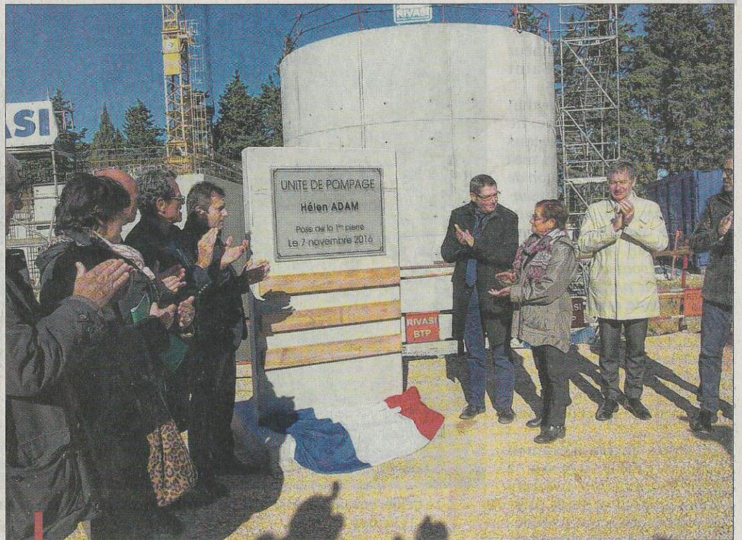
En présence des élus des communes concernées et des responsables du Syndicat Rhône Ventoux et de Suez Région Provence, le chantier de la nouvelle unité de pompage Hélen-Adam a été lancé. / PHOTO G.T.
