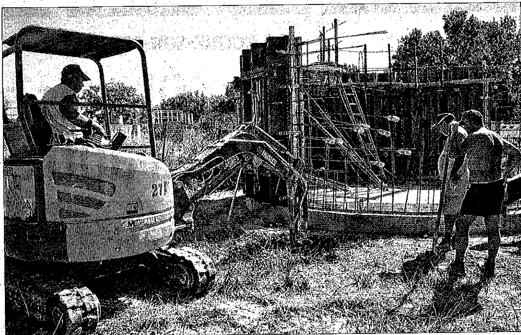
Les travaux ont débuté à proximité de la station d'épuration.
